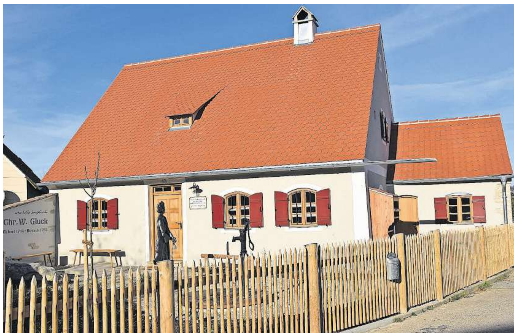
Das geschichtsträchtige Gluck-Haus in Weidenwang erstrahlt in neuem Glanz.
